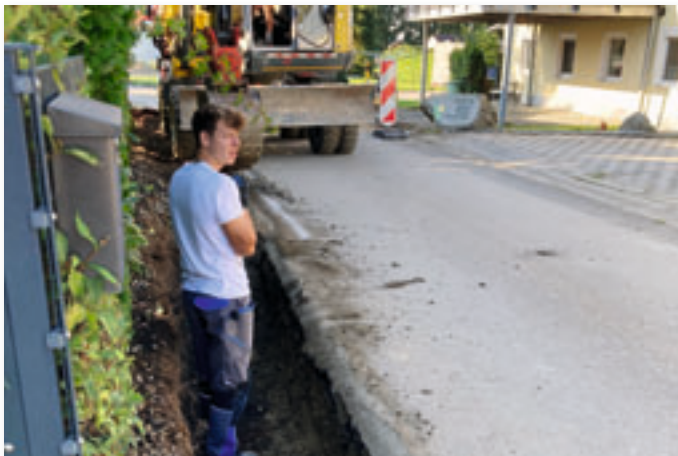
Die Mulden wurden vertieft und die Wasserdurchlässigkeit verbessert.
