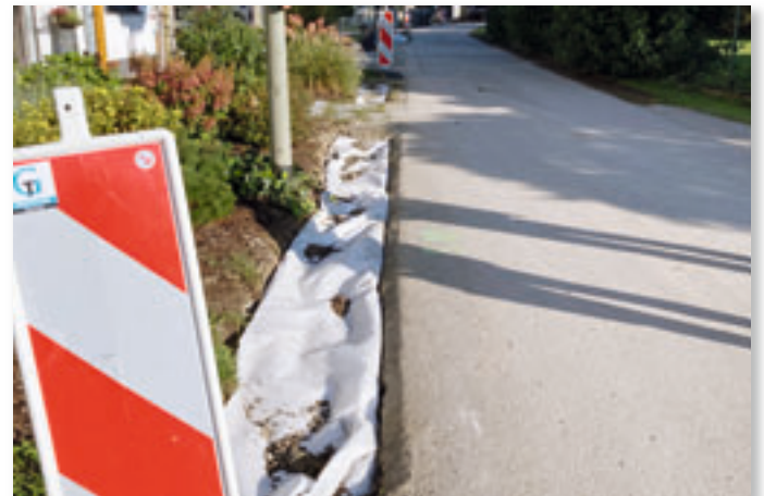
Versickerungsmöglichkeiten wurden am Fahrbahnrand eingebaut.
