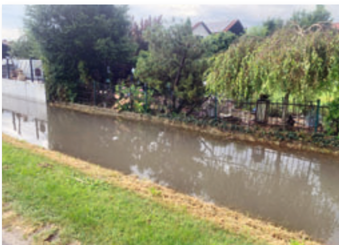
Der Lohgraben nach einem Starkregenereignis
