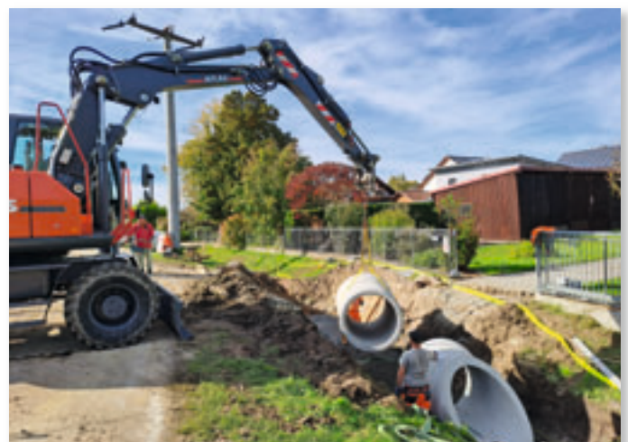
„Tiefbauarbeiten“ im wahrsten Sinne des Wortes
